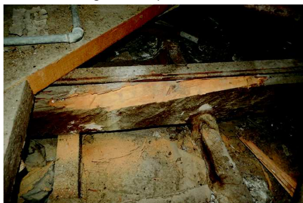
Figure 8: Poutre secondaire attaquée par des insectes 1
