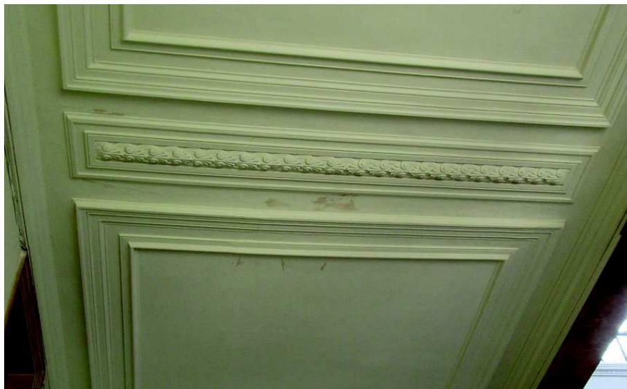
Figure 3: Fissurations et traces d'infiltrations
