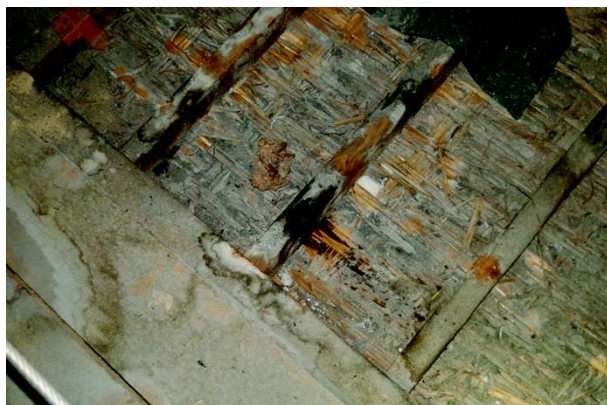
Figure 7: Traces d'infiltration sur solive et canisse2
