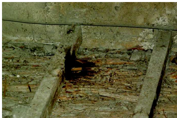
Figure 6: Traces d'infiltration sur solive et canisse 1
