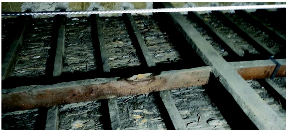
Figure 19: Poutre secondaire de section réduite
