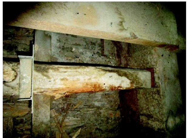
Figure 16: Bois attaqué par des insectes
