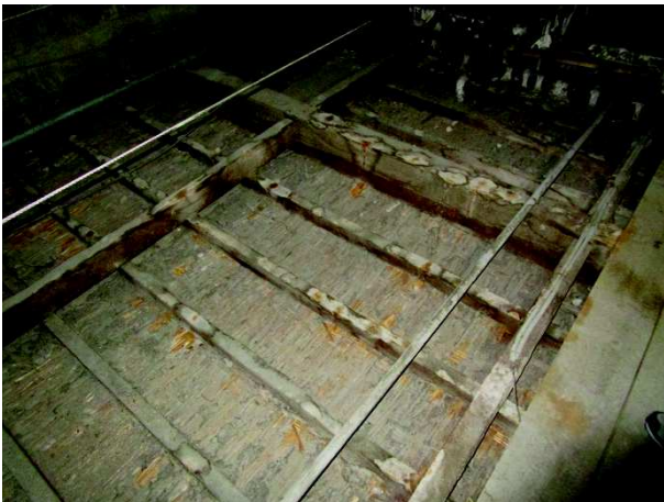
Figure 15: Multiple trace de pénétration d'eau
