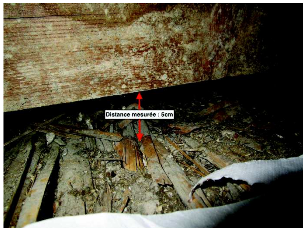
Figure 4: Faux plafond détaché des solives
