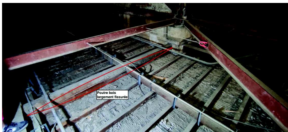
Figure 17: Poutre d'angle à renforcer
