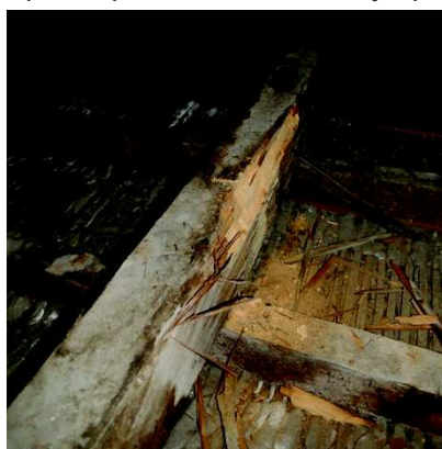
Figure 9: Poutre secondaire attaquée par des insectes2
