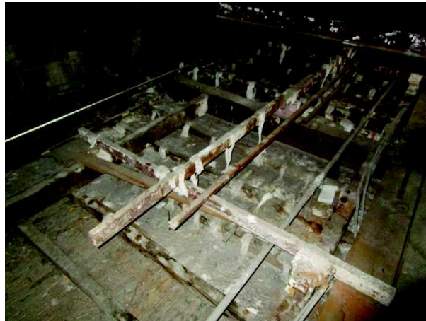
Figure 18: Renforcement anarchique et peu qualitatif
